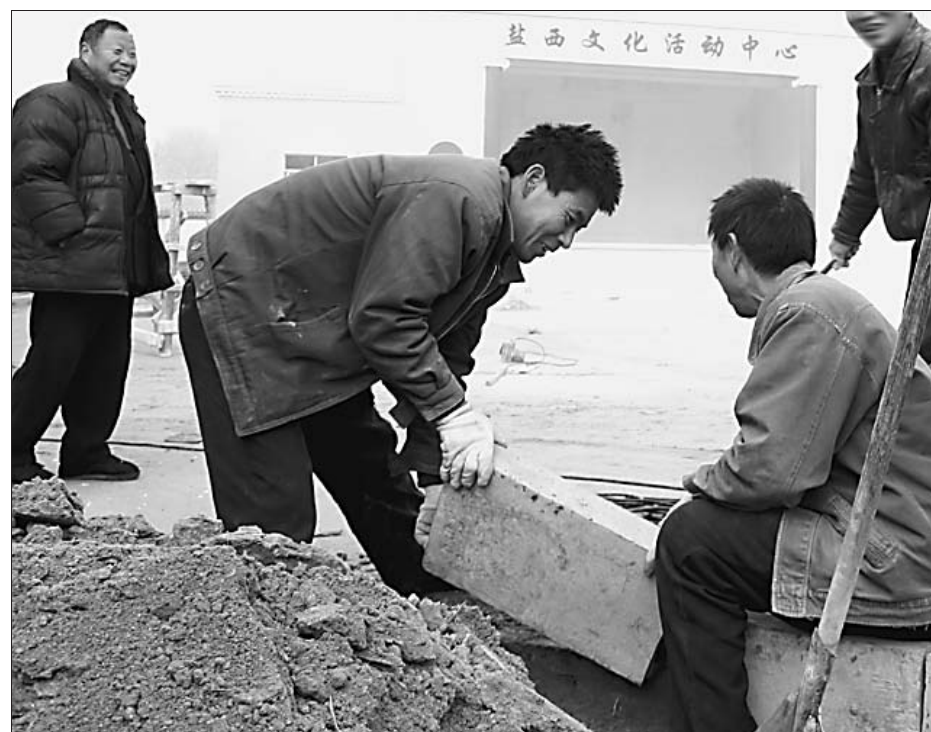
孟州市南庄镇盐西村围绕新农村建设,近日投入127万建起了文化大院旨在利用文化大院引导群众开展健康向上的文体活动,促进村民邻里和睦、民风好转。图为施工人员正在文化大院建设花池。本报记者 何金玲 摄
