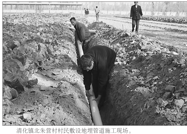
清化镇北朱营村村民敷设埋管施工现场。
