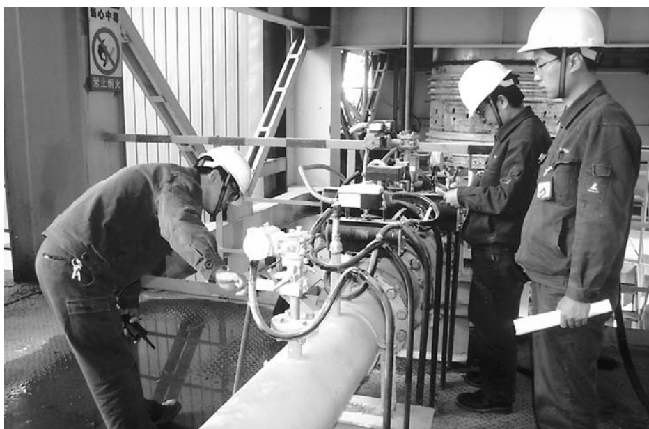
近日, 中铝中州分公司氧化铝厂开展了各种专项检查活动, 以确保安全生产。图为该厂七车间员工正在对内通焙烧炉的运行状况进行检查。 王玉霞 摄
