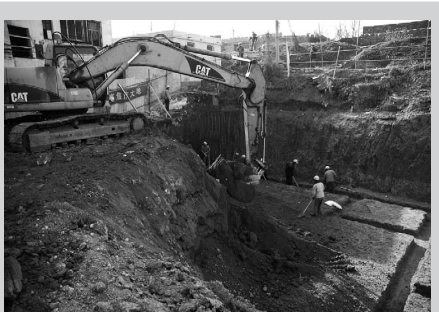
近日,我市2007年市政建设重点工程之一的新园西路穿越焦作电厂铁路专用线铁路立交工程箱桥基坑开挖基本结束。据现场施工人员介绍,该立交桥长9米,宽45.9米,采
