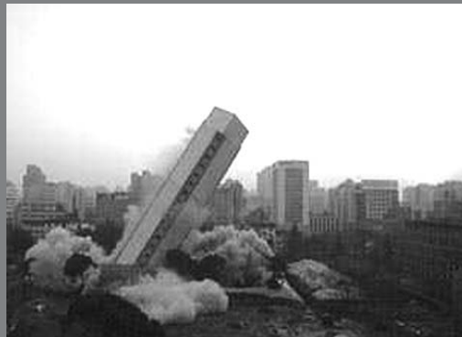
“西湖第一楼”爆破后产生5000立方米建筑垃圾
