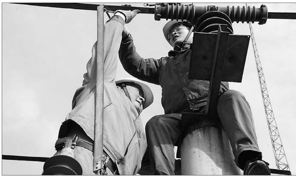
进入冬季以来,为确保广大居民生产、生活用电,博爱县电业局积极开展“巡视电力设备一条心,服务电力客户用真心”活动。图为11月30日,该局的技术人员在变电站对室外电气设备进行检修。程刚 摄
