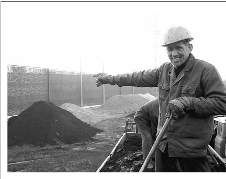
河南纳士科技股份有限公司北厂区二次料场扬尘治理工程于近日竣工。该厂防扬尘网投入使用后,北厂区二次料场的自然风通过防风抑尘网可使平均风速下降百分之八十左右,对阻挡粉尘和减缓粉尘飘移将产生良好的效果。 本报记者 何金玲 摄
