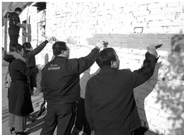
连日来,山阳区太行街道办事处积极组织机关工作人员深入基层,帮助各村、社区进行沿街墙体、楼体粉刷,受到了辖区居民的一致好评。图为该办事处的工作人员正在牛庄村粉刷墙体。 王魁 摄
